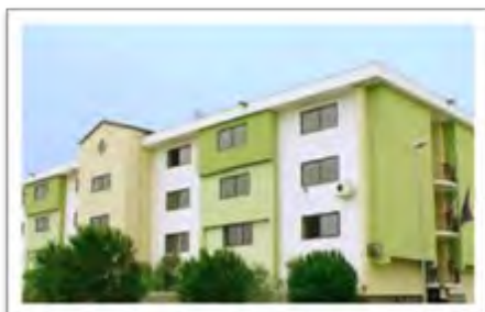
I.T.I. DI CORIGLIANO CALABRO (SEDE CENTRALE)
